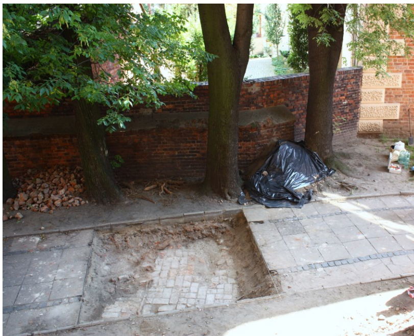
Ryc. 3. Toruń – kościół św. Jakuba. Odslonięta w wykopie W-12/13 posadzka łącznika (fot. A. Cicha)
