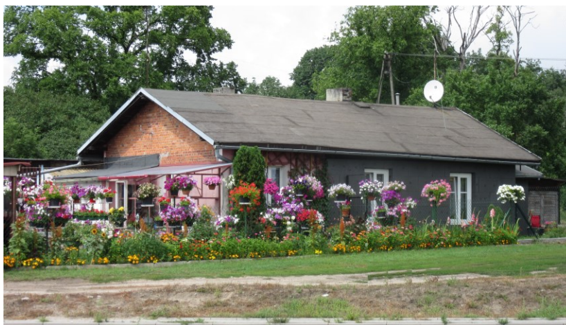
Ryc. 2. Dom walmistrza przy Forcie V (wtórnie przebudowany), stan z 2016 r. Fot. P. Nastrożny
