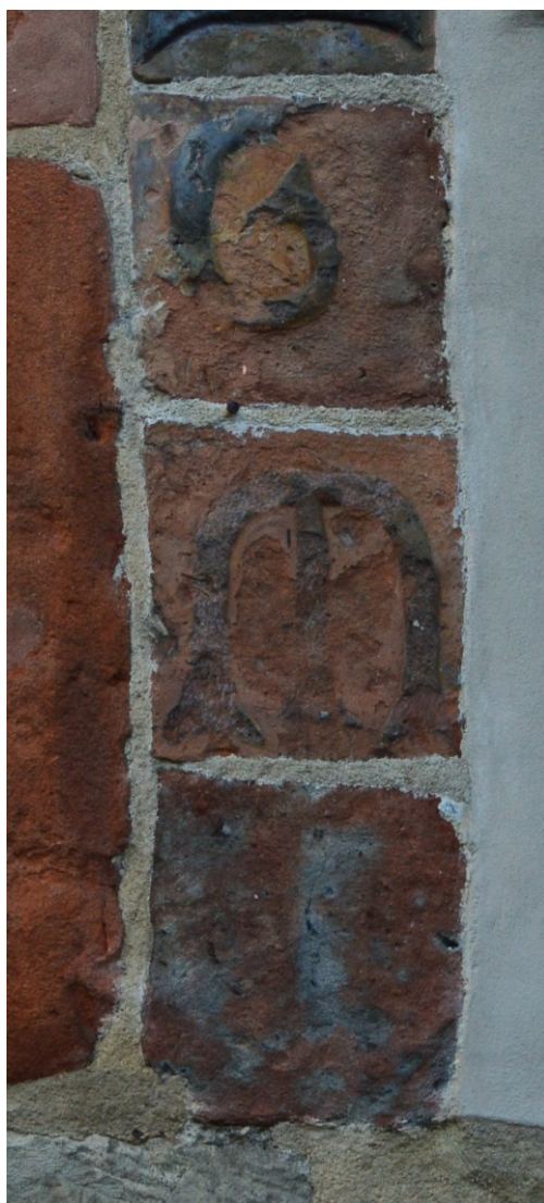
Il. 7. Fragment inskrypcji/fryzu literowego portalu zamku bierzgłowskiego – po prawej stronie (fot. M. Dzienis)
