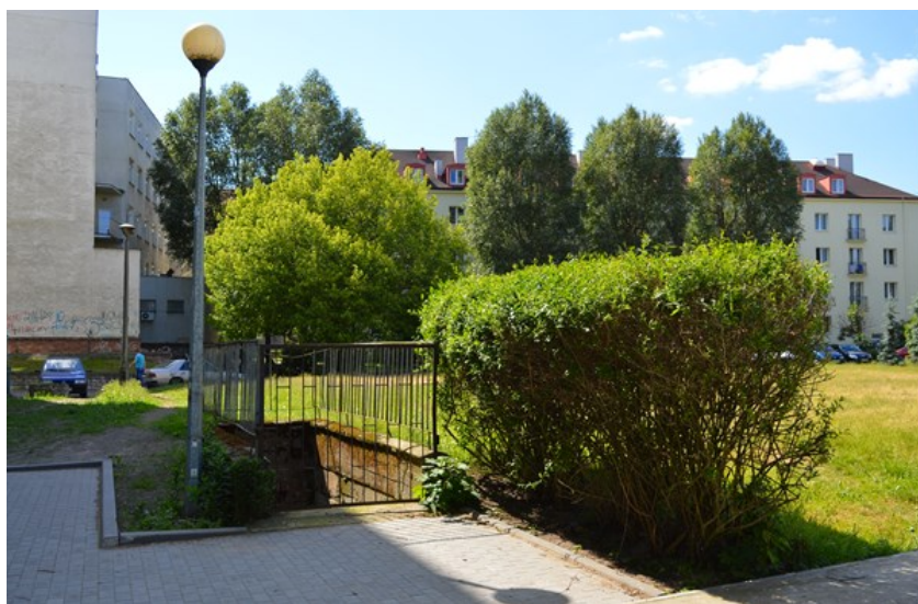
Zejscie do zasypanej piwnicy baraku akademickiego na ul. Mickiewicza. Fot. M. Napiórkowski, 2015
