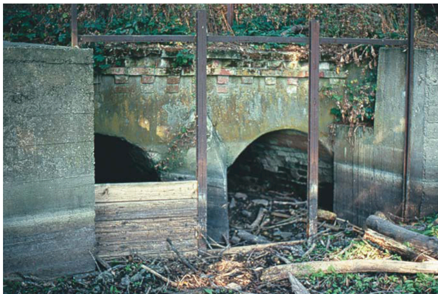
Fot. 2. Zamulony staw młyński i zniszczone urządzenia piętrzące młyna Brzozówka na Skrwie Lewej
